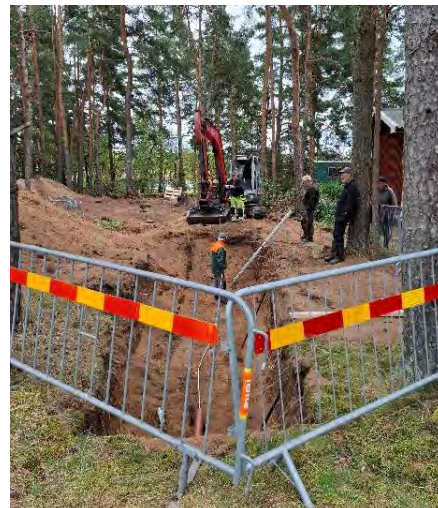
Det grävs lite här och där på ön. Nu pågår många olika VA-arbeten med enskilda avlopp på Vinön.
